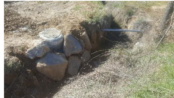
Traversée du cours d'eau
