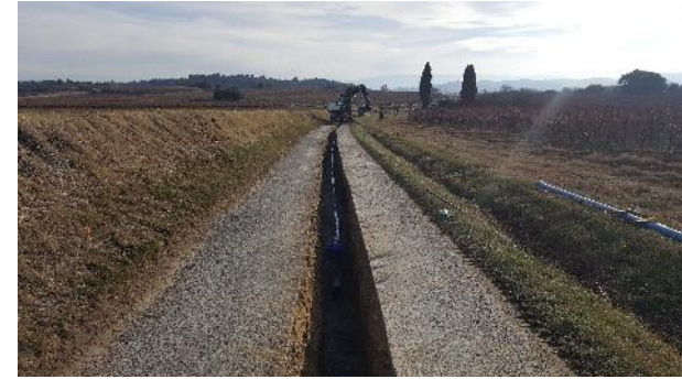
Remblaiement de tranchée
