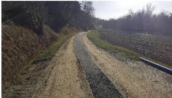
Réfection de chaussée
