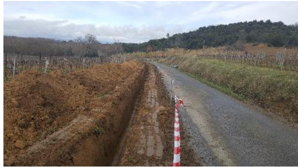
Ouverture de tranchée
