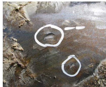
pioche / canalisation acier gaz HP
