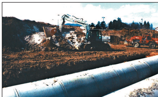
Figure 5. Chantier mobile utilisant un godet cribleur
