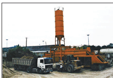
Installation fixe de Gravi France à Bondy (93)
